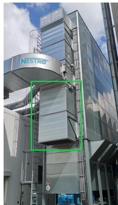
Späneabsauganlage vorher ohne Schalldämpfer      Späneabsauganlage nachher mit Schalldämpfer
